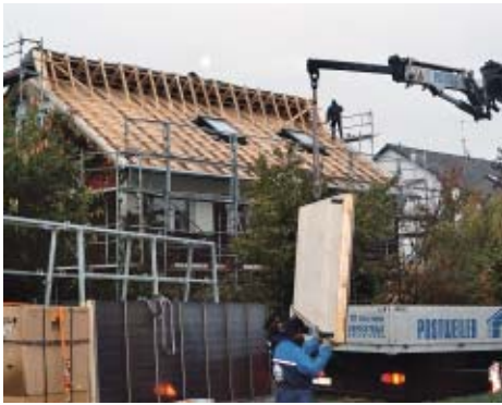
Noch ist nicht zu erkennen, dass das Dach dieses Altbaus schon bald in „blauem Glanz“ erstrahlen wird.
