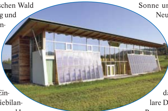
110 m 2 Kollektoren sorgen für 100 Prozent sonnige Wärme. Im Februar feierte das Naturparkhaus sein dreijähriges Bestehen.
