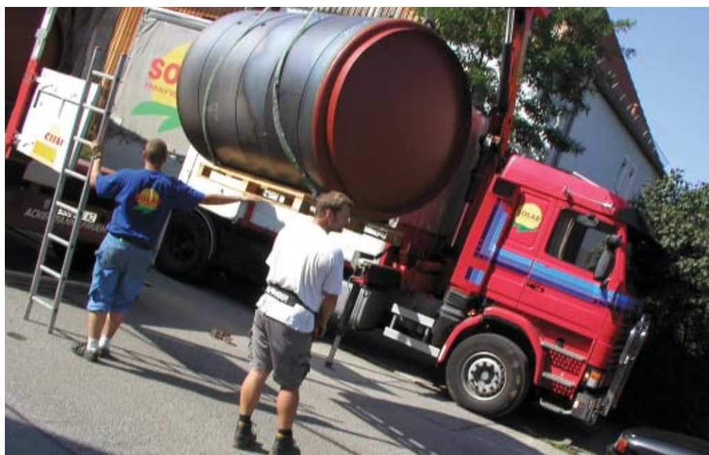
Ein großer Moment: Der Solarspeicher, hier noch in Einzelteilen zusammengesetzt, wird angeliefert.
