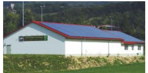
Drei Anlagen mit insgesamt 50 kWp Leistung fanden auf dem Dach dieses Vereinsheimes Platz.
