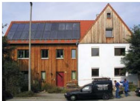
Auch Altbauten können zu Sonnenhäusern umgerüstet werden.
