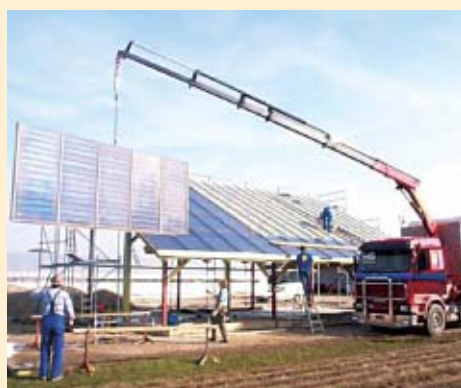
Durch Kranmontage können Zeit und Kosten gespart werden.
