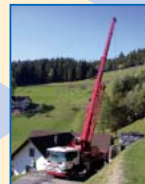
Vorsichtig wird der Kollektor angehoben.
