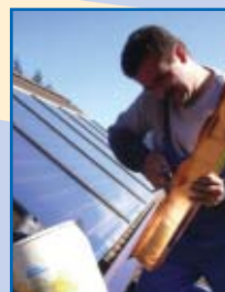
Letzte Arbeiten auf dem Dach, während auch im Keller fleißig gearbeitet wird.
