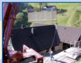
Da schweben sie, 16 qm Sonnenkollektoren in einem Stück.
