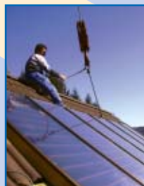
Passgenau wird der Kollektor eingelassen.
