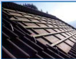
Die Ziegel sind entfernt, es kann losgehen.
