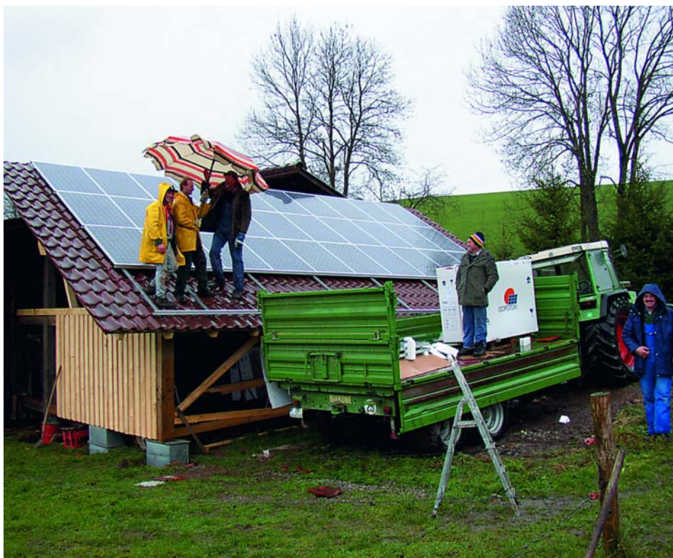
Viel Spaß bei der Montage hatte das Allgäuer Photovoltaik-Team.
