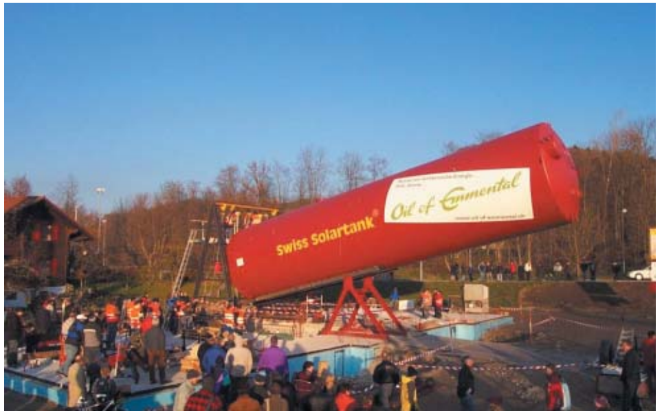
Der Schwerkraft sei Dank: Über den dreieckigen Bock kippte der Stahlkoloss langsam in die Grube. Hier brachten die Fachleute ihn in seine endgültige aufrechte Position.
