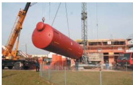
In Regensburg entsteht das erste vollständig solar beheizte Massivhaus ohne Zusatzdämmung. Im November wurde der 39.500-Liter-Speicher aufgestellt, wenig später war das 40° geneigte Süddach mit 84 m 2 Sonnenkollektoren eingedeckt. Ein neuer Wärmedämmziegel ermöglicht das Pilotprojekt auf dem Gebiet Massivbau und solares Heizen.
