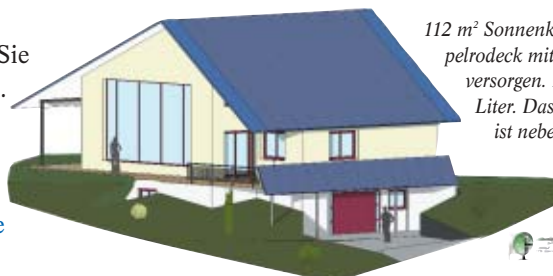
In Regensburg entsteht das erste vollständig solar beheizte Massivhaus ohne Zusatzdämmung. Im November wurde der 39.500-Liter-Speicher aufgestellt, wenig später war das 40° geneigte Süddach mit 84 m 2 Sonnenkollektoren eingedeckt. Ein neuer Wärmedämmziegel ermöglicht das Pilotprojekt auf dem Gebiet Massivbau und solares Heizen.
