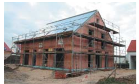
In Regensburg entsteht das erste vollständig solar beheizte Massivhaus ohne Zusatzdämmung. Im November wurde der 39.500-Liter-Speicher aufgestellt, wenig später war das 40° geneigte Süddach mit 84 m 2 Sonnenkollektoren eingedeckt. Ein neuer Wärmedämmziegel ermöglicht das Pilotprojekt auf dem Gebiet Massivbau und solares Heizen.
