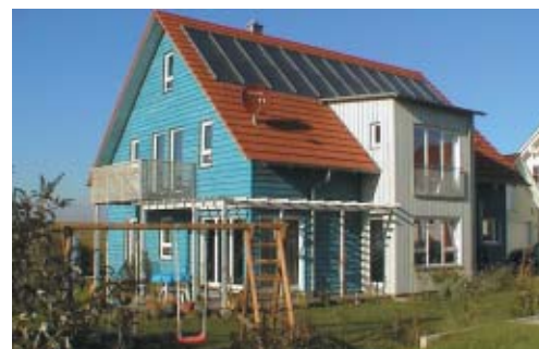
In der „Casa Azul“, dem „blauen Haus“ der Familie Müller, sorgen 36 m 2 Sonnenkollektoren für eine wohlige Wärme. Für die restlichen 40% Energiebedarf für die Heizung und warmes Wasser sorgt ein Stückholzvergaserkessel.
