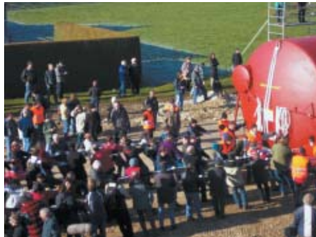
Über 100 Freiwillige halfen, den 15 Tonnen schweren Speicher von der Produktionshalle der Jenni Energietechnik AG zum Bauplatz des ersten rein solar beheizten Mehrfamilienhauses zu ziehen.
